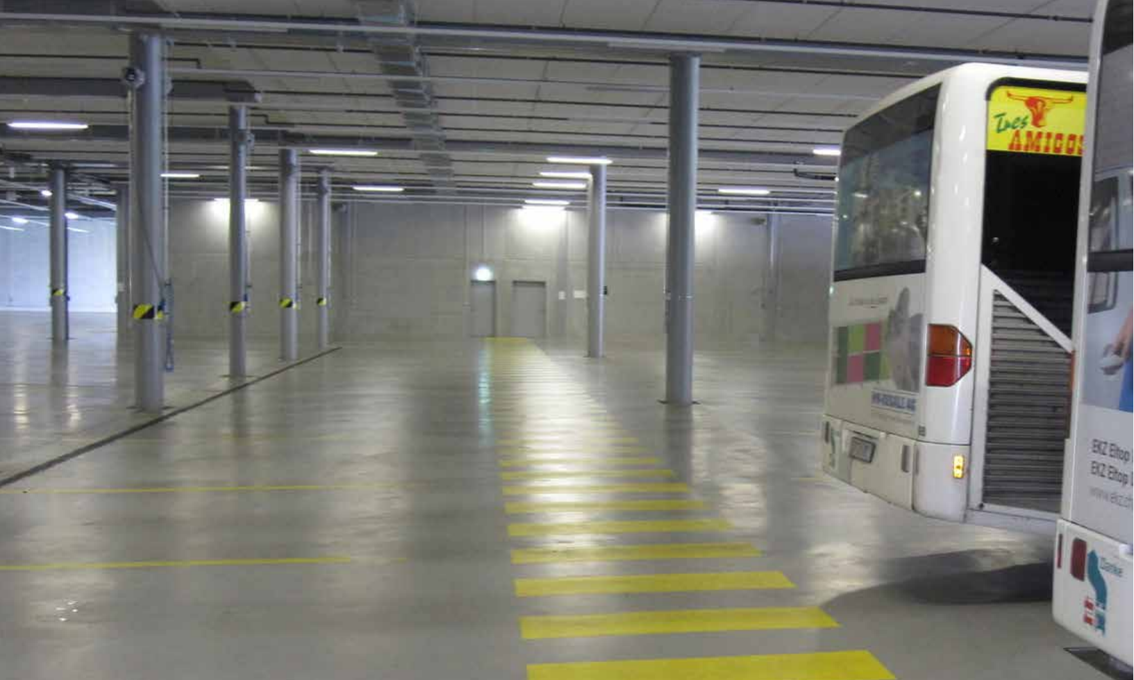
Autobusový terminál vo Švajčiarsku, podlahy vystužené s Fibrofor High Grade 1 kg/m 3 betónu
