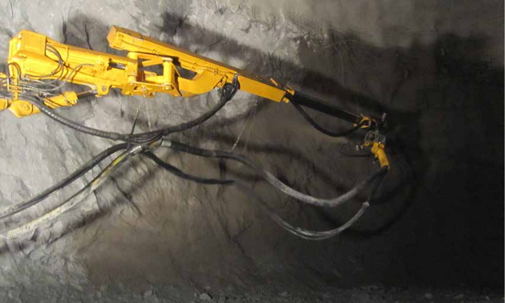
Test striekaného betónu pre tunelové aplikácie
